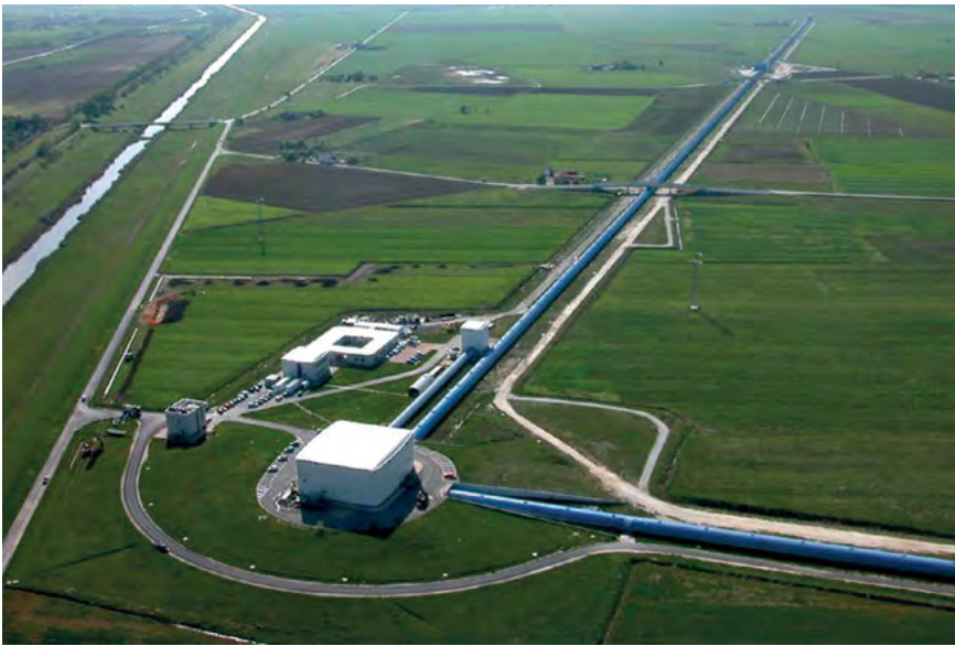
Aerofoto Virgo interferomeetrist Itaalias Toscanas. Detektori kolme kilomeetri pikkustes harudes peegelduvad edasi-tagasi laserikiired, mille abil saab mõõta vahemaid, mis hõlmavad tuhandiku prootoni läbimõõdust
